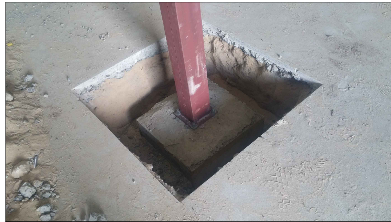
IMAGEN DE REFERENCIA OBRA ENTREPISO EXISTENTE BASES DE COLUMNAS
