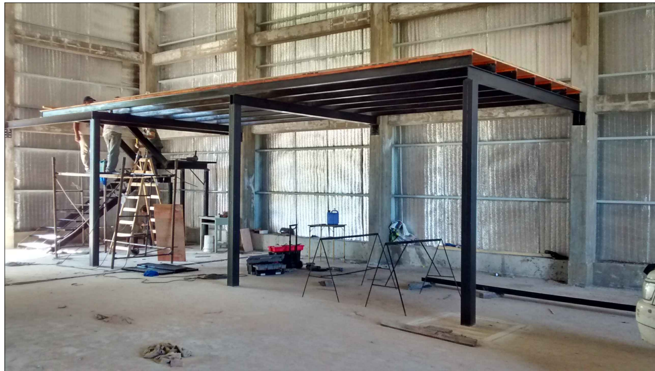
IMAGEN DE REFERENCIA OBRA ENTREPISO EXISTENTE COLUMNAS METALICAS Y ENTREPISO
